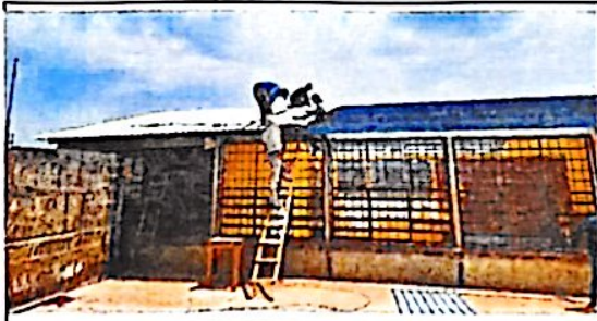
Foto 1: DURANTE EL CAMBIO DE TECHO
