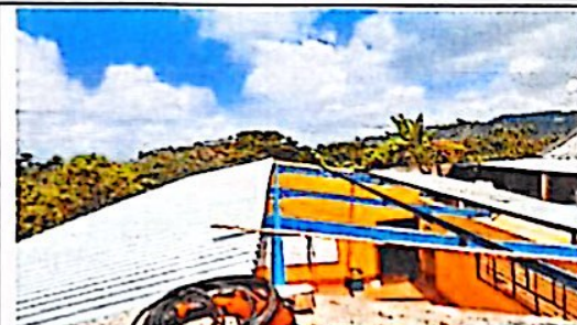
Foto 2: DURANTE EL CAMBIO DE TECHO
